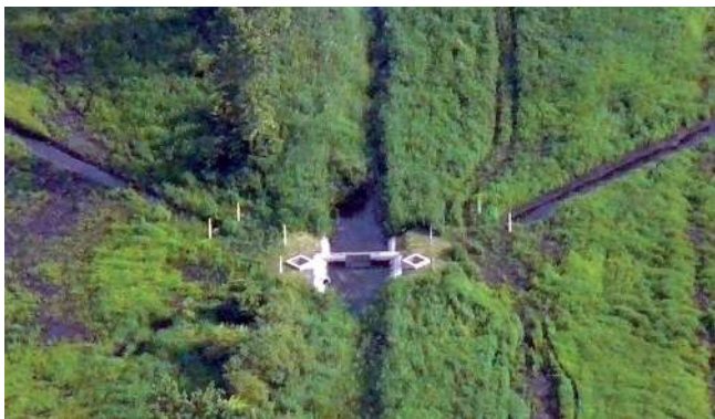
7. ábra. A Kétöles-patakon létesített, „pallós” zsilip. (Fotó: Cservenka J.)
