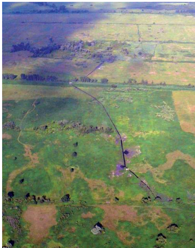
8. ábra. A Kétöles-patakon létesített csatornák és „békabölcsők”. (Fotó: Cservenka J.)
